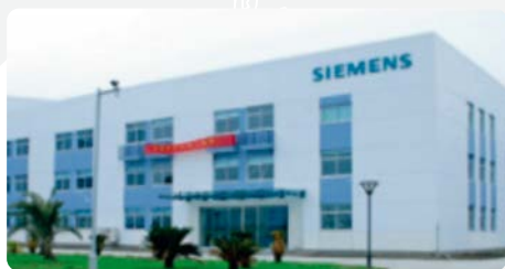
苏州西门子电器有限公司天台分公司 (制造基地)
